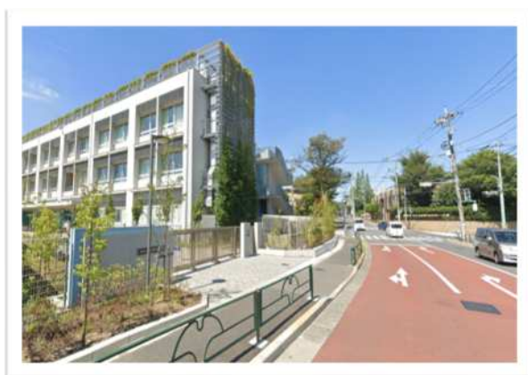
▲都市計画道路に面した学校 【石神井小学校】
