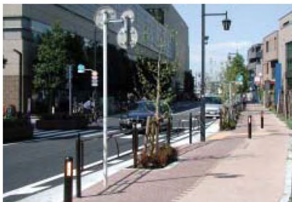
（都市計画道路補助132号線：石神井公園駅付近）
