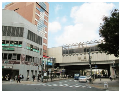
千川通りから見る練馬駅
