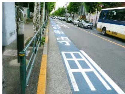
車道を狭めて整備した、早く走れる自転車レーン（渋谷区本町）
