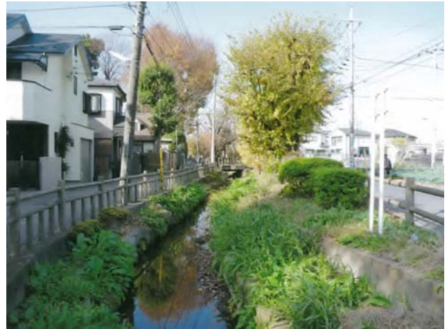
清流復活事業で整備された千川上水（関町南四丁目）
