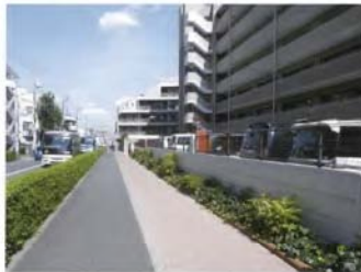
敷地後退により生み出された通路（オレンジ色の部分）仕上げの違いが計らずも歩行者と自転車の通るゾーンを意識させる。 生活幹線道路（富士街道 関町北五丁目）
