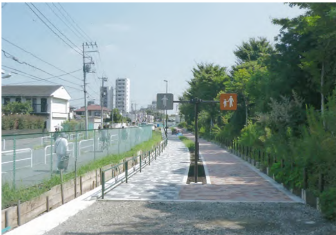
拡幅事業が進む千川通り。右に既存の緑道公園、歩道には自転車レーン。 （上石神井一丁目）
