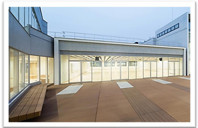
▲校舎屋上【豊玉第二中学校】
