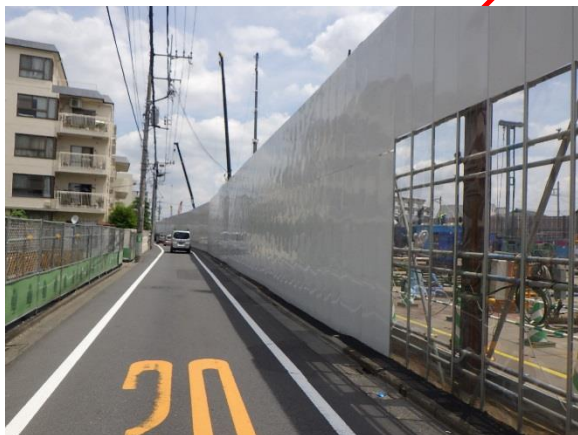
防音パネル(5m)設置イメージ
