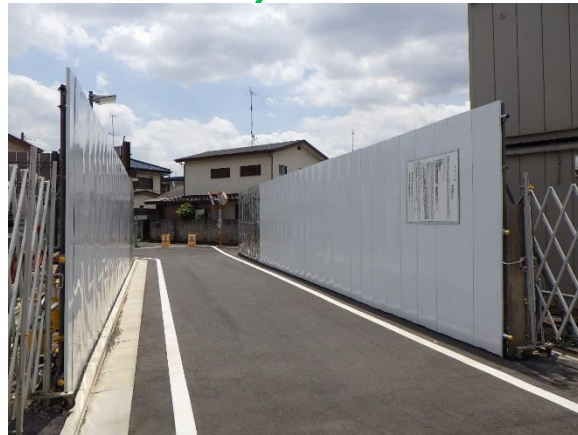
防音パネル(3m)設置イメージ
