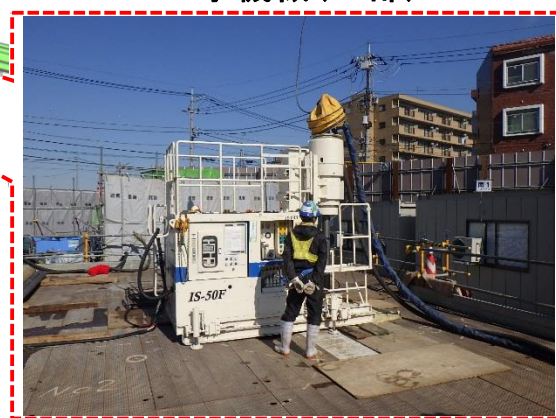
工事機械(一部)
