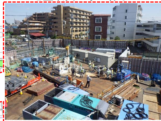
地盤改良工事の様子
