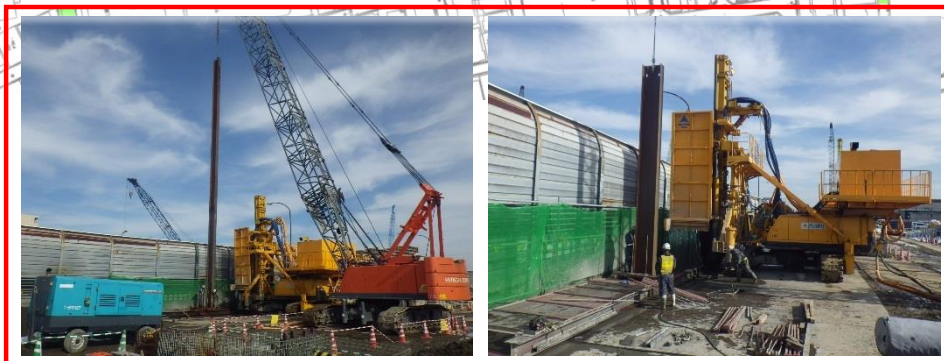
地中連続壁施工の様子
