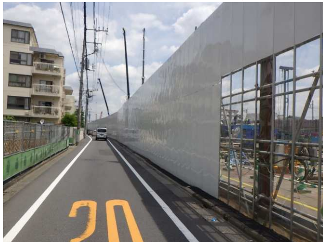
防音パネル(5m)設置イメージ
