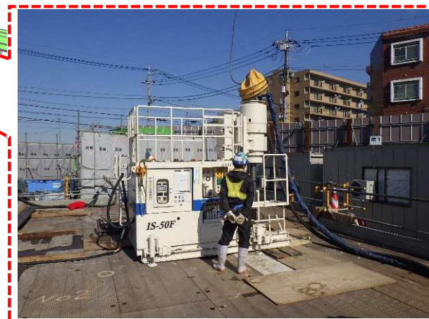
工事機械(一部)
