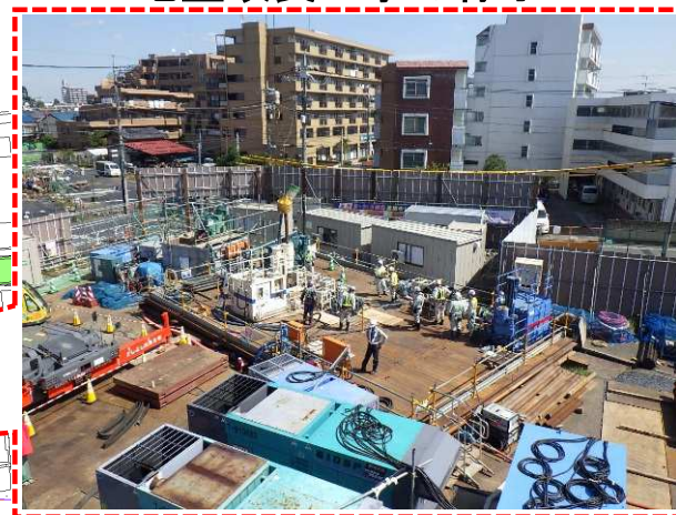
地盤改良工事の様子
