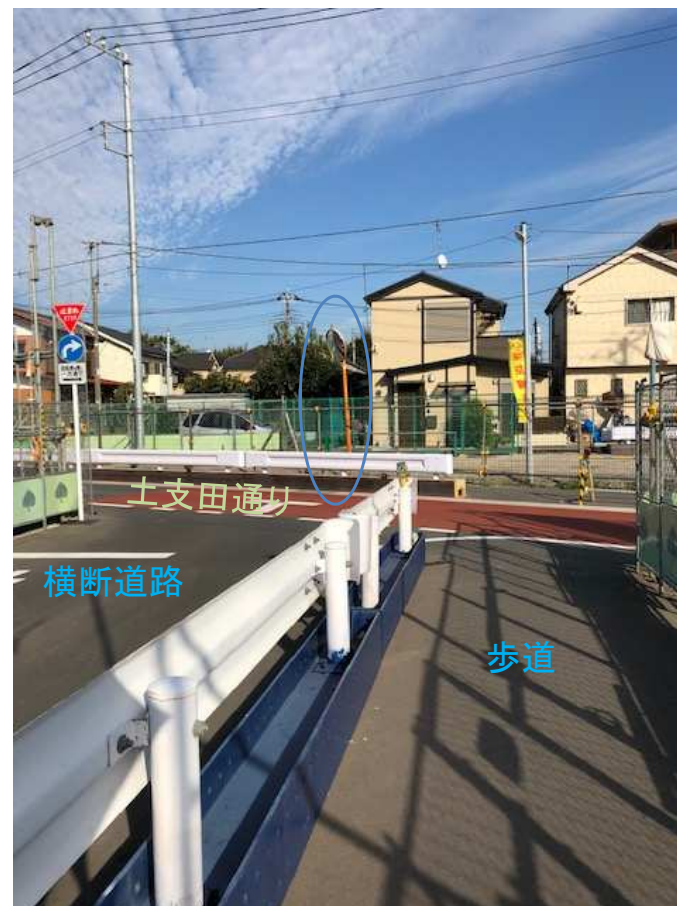
土支田通り側出口正面に カーブミラーを設置
