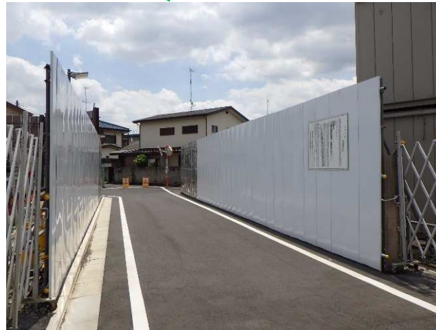
防音パネル(3m)設置イメージ
