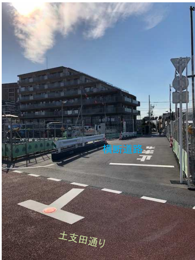
横断道路を新設
