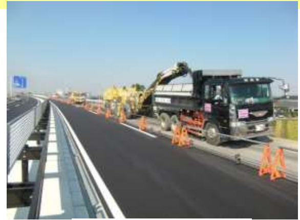
切削機による舗装撤去
