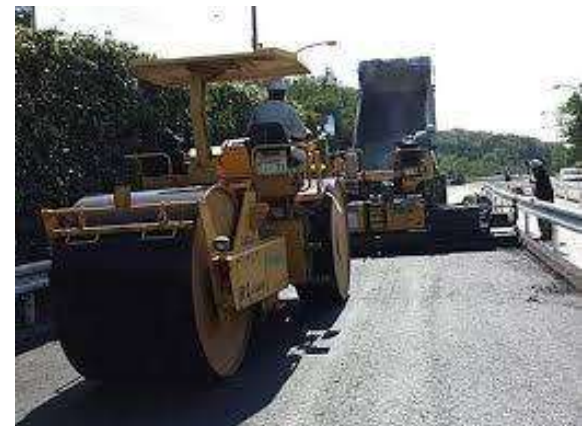
アスファルトフィニッシャーによる舗設状況
