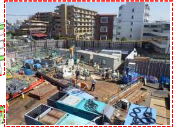
地盤改良工事の様子
