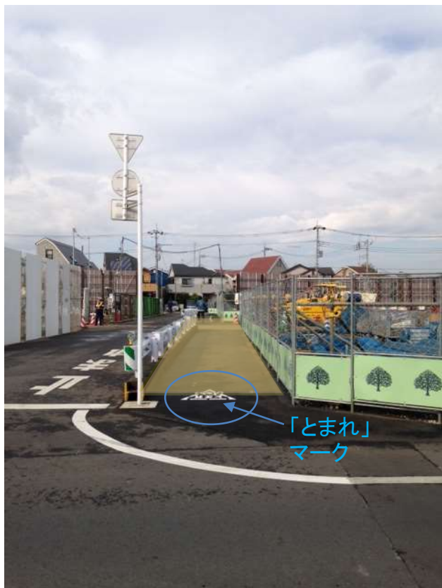
新設歩道 (土支田通り側より)
