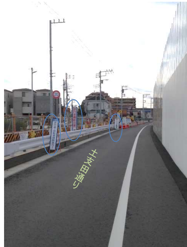
道路沿いに 安全看板を設置
