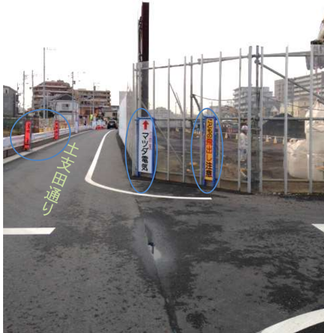
仮囲いに迂回路、安全看板 を設置
