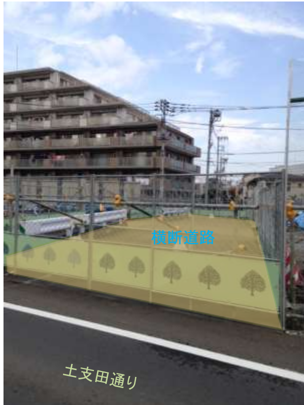
横断道路を新設
