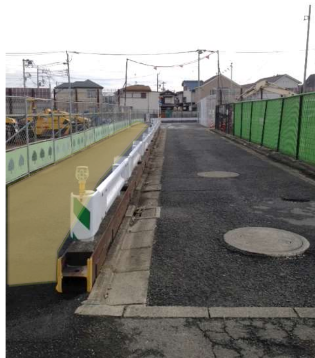
新設歩道 (区道側より)
