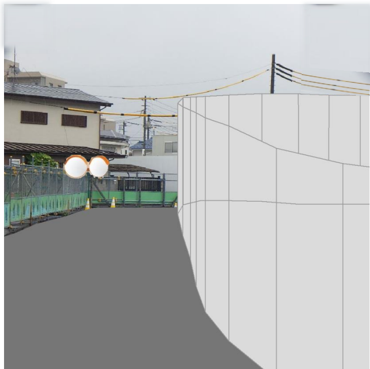
切回し道路の曲がり角に カーブミラーを設置
