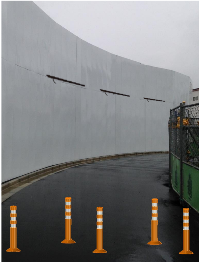
車いすの方が通れる幅（1.0m）で ポールコーンを設置
