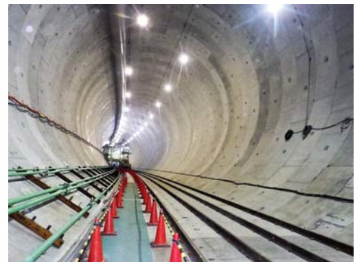
トンネル内部の写真(イメージ)
