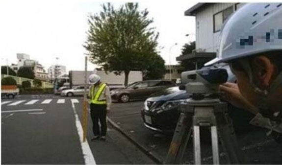
地上部での作業(イメージ)
