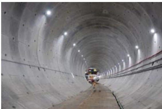
トンネル内部の写真(イメージ)
