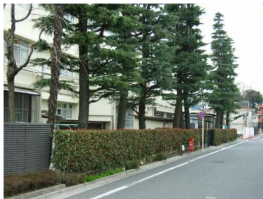
境界部に高木のヒマラヤスギと調和した生垣を整備した例。(開進第四中学校)
