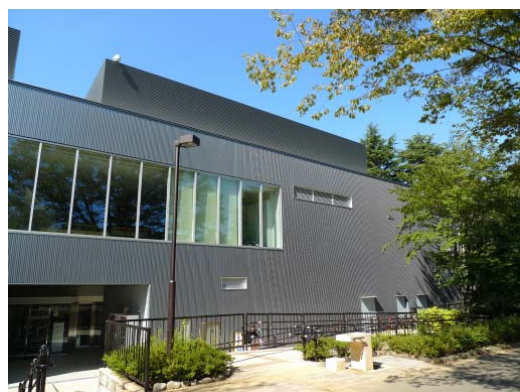
屋上の設備類を隠すとともに、圧迫感を与えないよう後退させ、周囲（ここでは、隣接した旧内田家）に配慮している例。(石神井公園ふるさと文化館)
