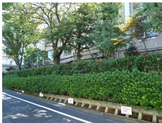
法面を緑化し、緑のボリュームを創出している例。コンクリート製のプランターを整備することで、緑化を実現している。(右写真)(開進第三中学校:左右とも)
