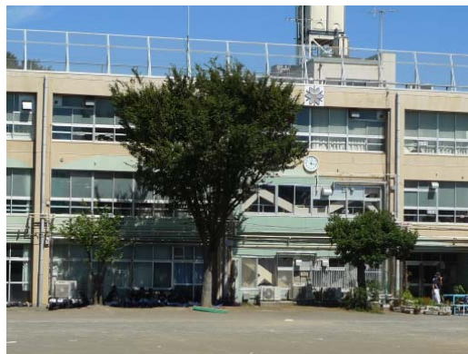
調和のとれた色を組み合わせることによって、大規模な面となる校舎のデザインを工夫している例。(橋戸小学校)
