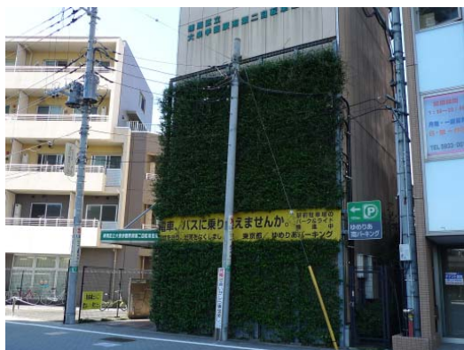
壁面全体を緑化している例。 (大泉学園駅南第二自転車駐車場)
