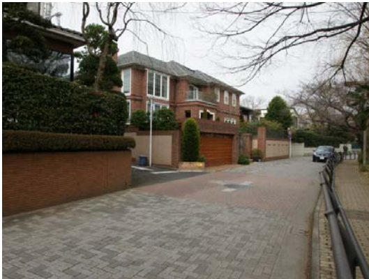
無電柱化とあわせ、車道部分についても散策路としてふさわしい色彩としている例。 （都立石神井公園北側道路）
