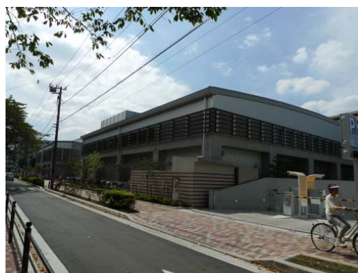
1階部分に植栽をするなど、沿道に対し圧迫感を抑えた例。(中村南スポーツ交流センター)
