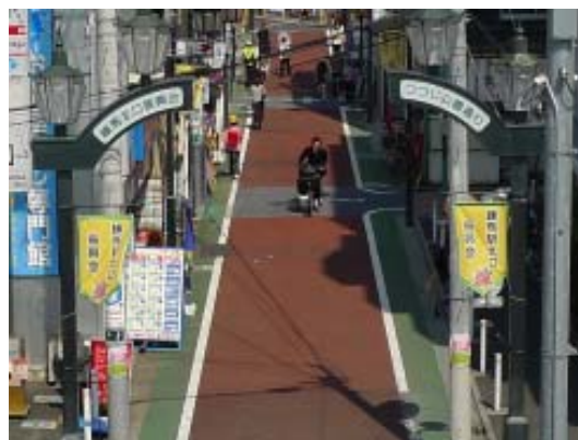
歩道、車道のカラー舗装。ここでは、車道が紅色系で歩道が緑色系となっている。交通安全を確保した上で色彩を調整する。
