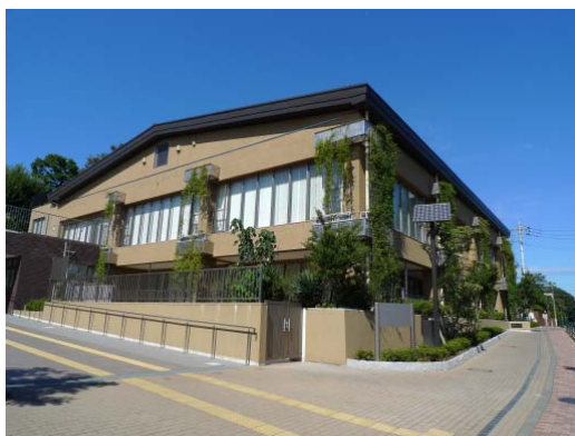
切り妻屋根や壁面の緑化により、周囲に建物の規模を感じさせないように工夫している例。(石神井図書館)
