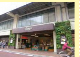
【事例】高架下を利用した商業施設（練馬高野台駅）
