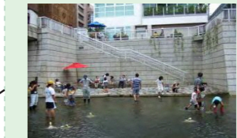
【事例】神田川親水テラス（高田馬場駅付近）
