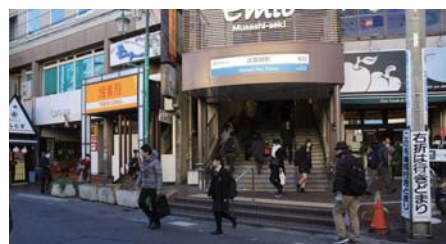
駅利用者が憩い集えるスペースが十分でない
