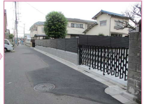
危険なブロック塀の撤去後
