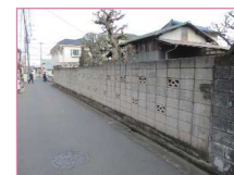
危険なブロック塀の 撤去前
