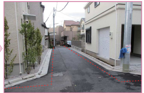
狭あい道路の拡幅後
