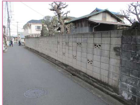
危険なブロック塀の撤去前
