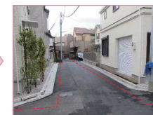
狭あい道路の拡幅後
