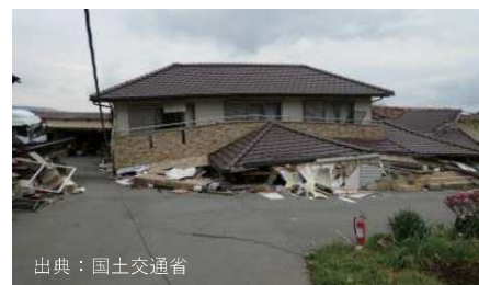
▲熊本地震で倒壊した新耐震木造住宅
