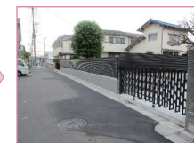
危険なブロック塀の 撤去後
