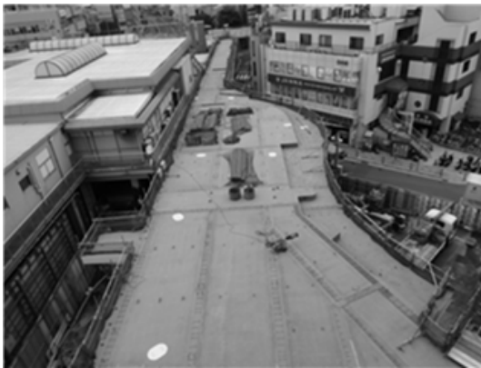
再開発ビル5階から撮影
