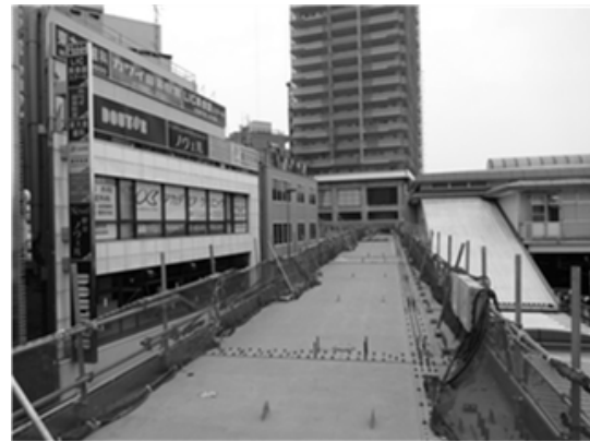
既存の南北連絡デッキから撮影
