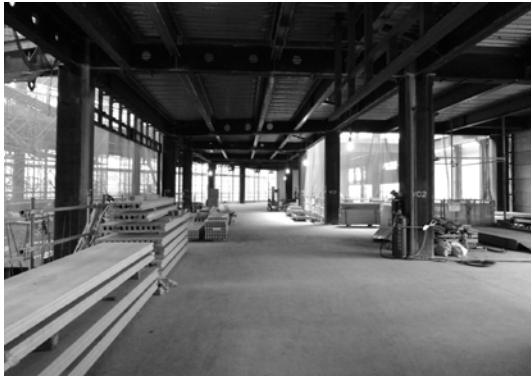
3階商業施設部分の工事の様子
