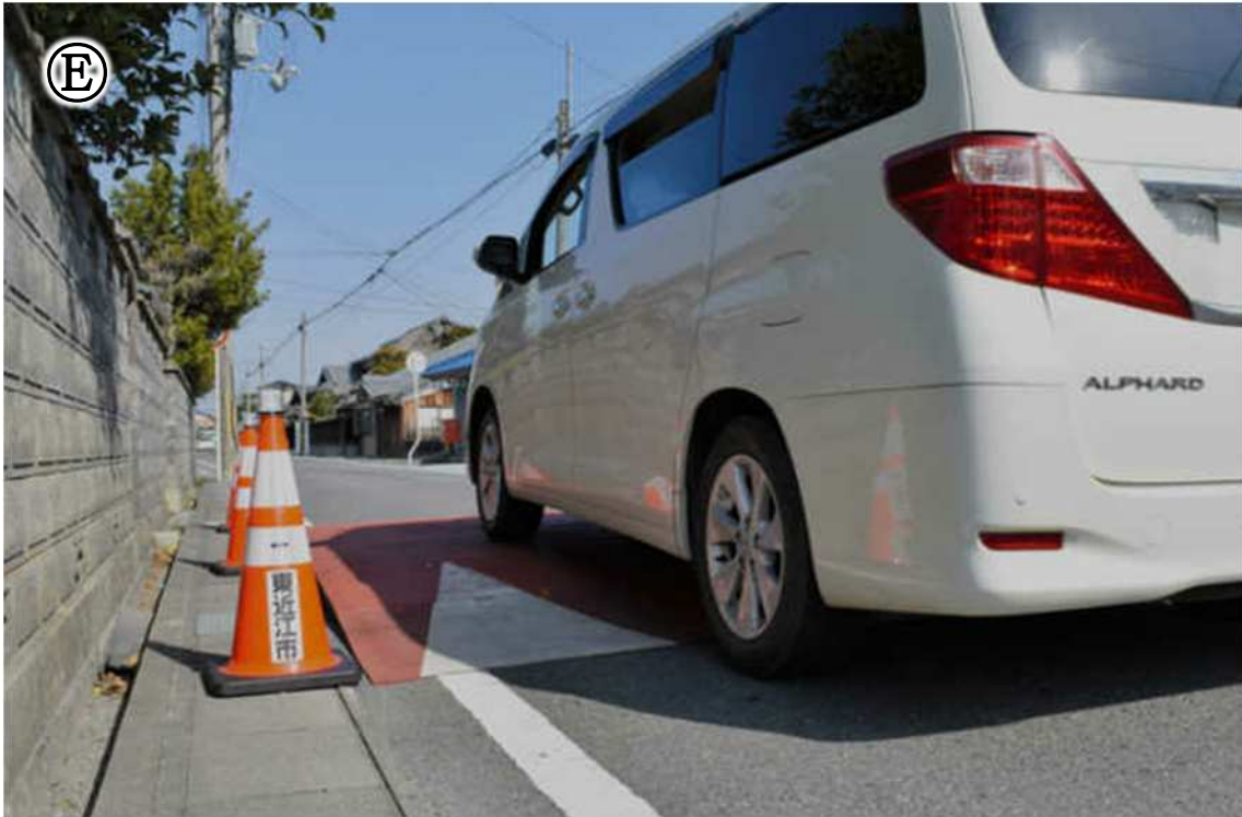
速度抑制のためにハンプを設置した例
