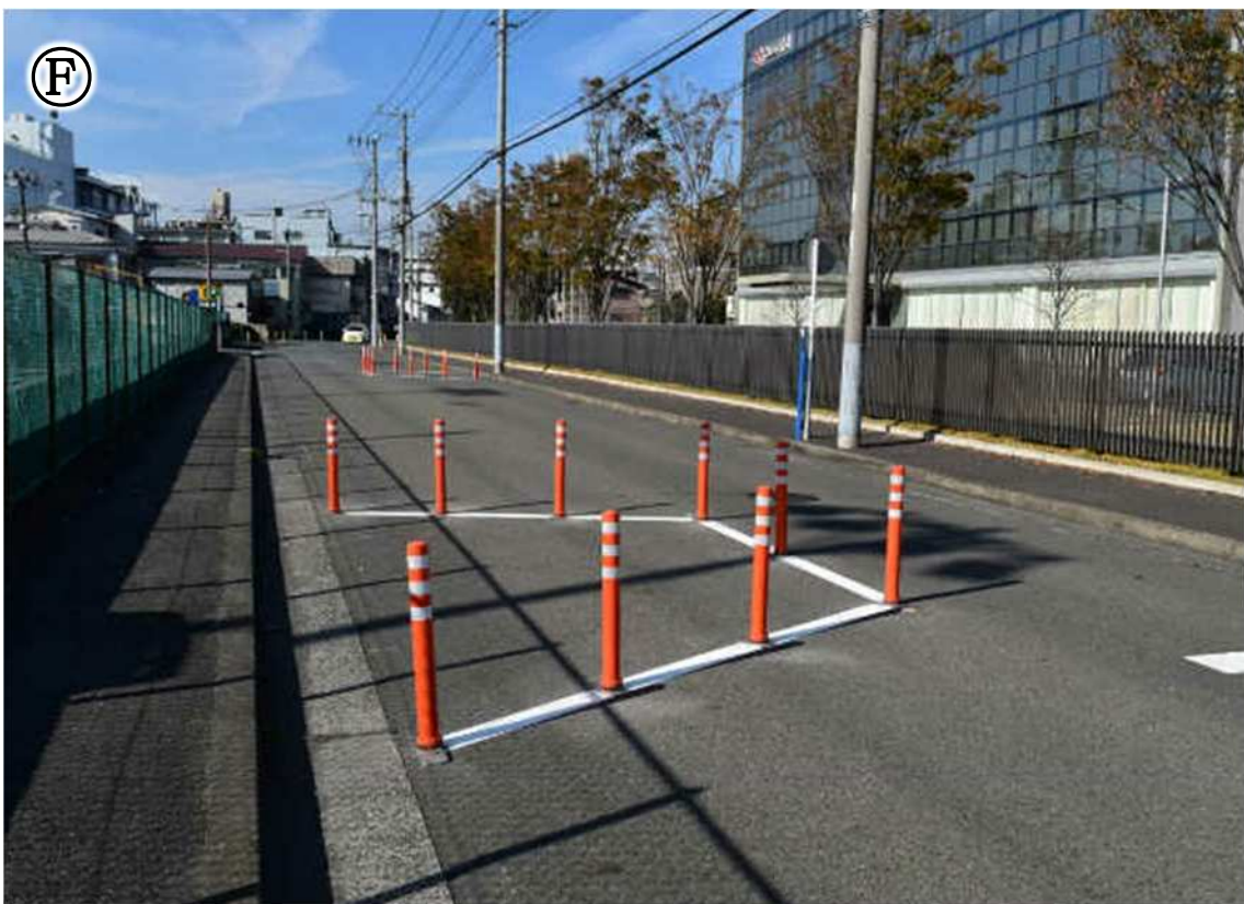
速度抑制のために狭さを設置した例
