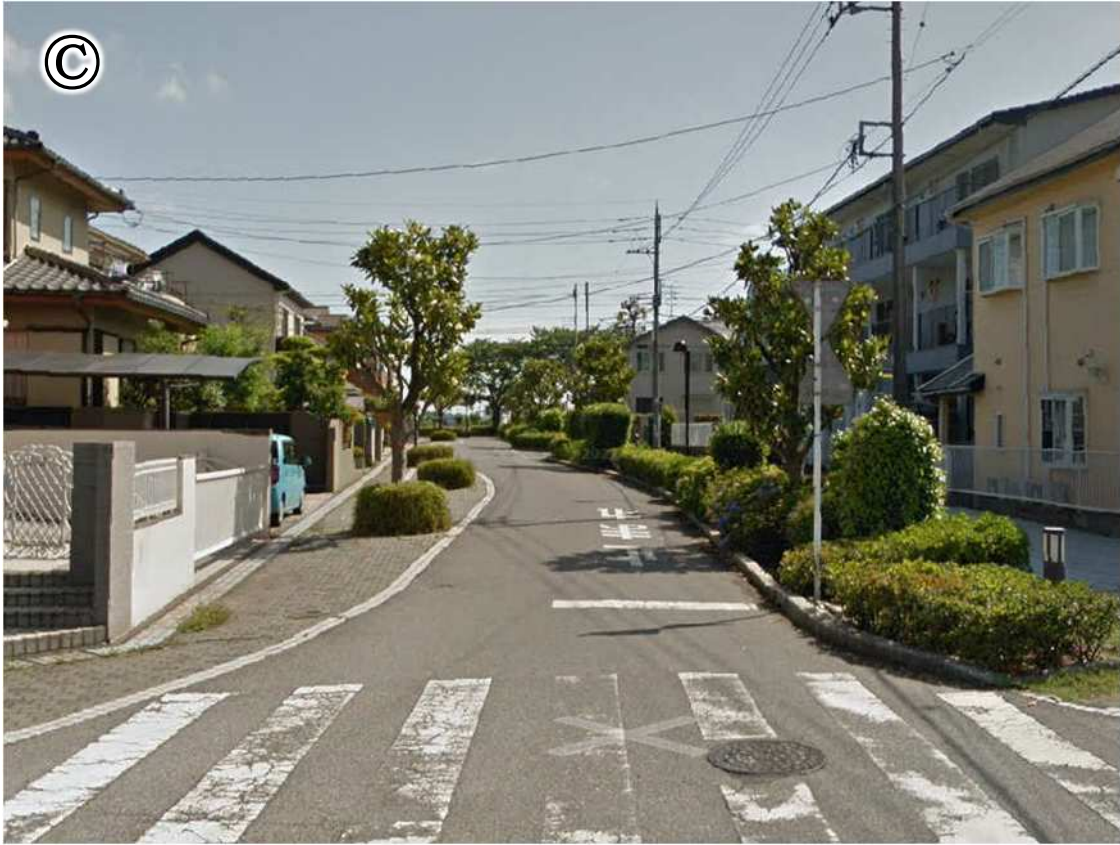
速度抑制のためスラロームにした例
