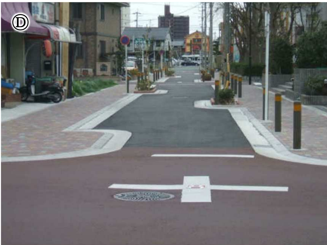
速度抑制のためクランクにした例
