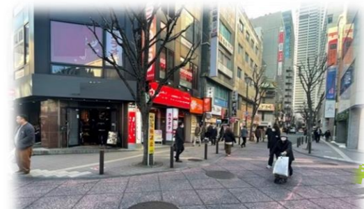
道路をインターロッキング舗装した例 (新宿駅西口プラザ通り)
