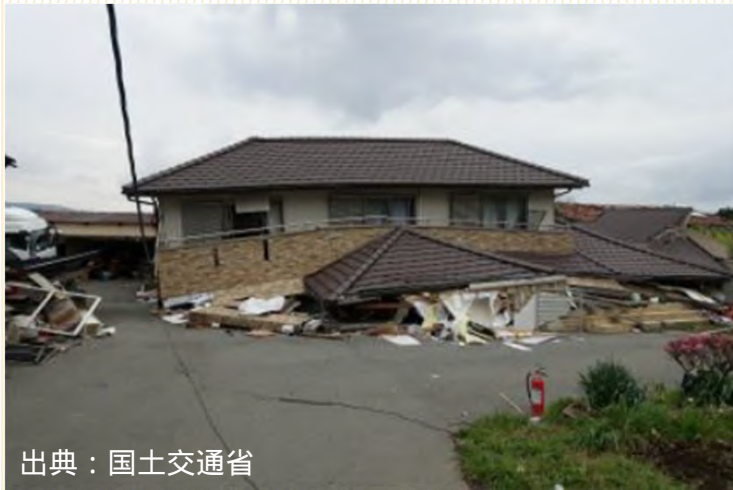
熊本地震で倒壊した新耐震木造住宅
