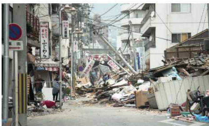
■阪神・淡路大震災写真（神戸市灘区）
