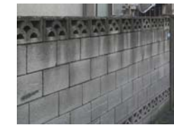
老朽化したブロック塀は地震で倒れると危険
