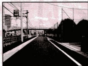
主要生活道路2号線(1期) [道路整備]
