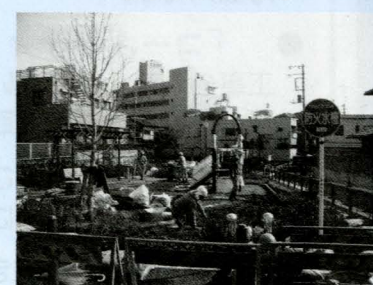
【現況】（整備工事の様子）
