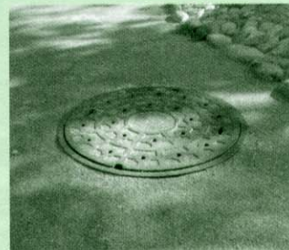
【災害時にトイレとして利用できる汚水樹】
