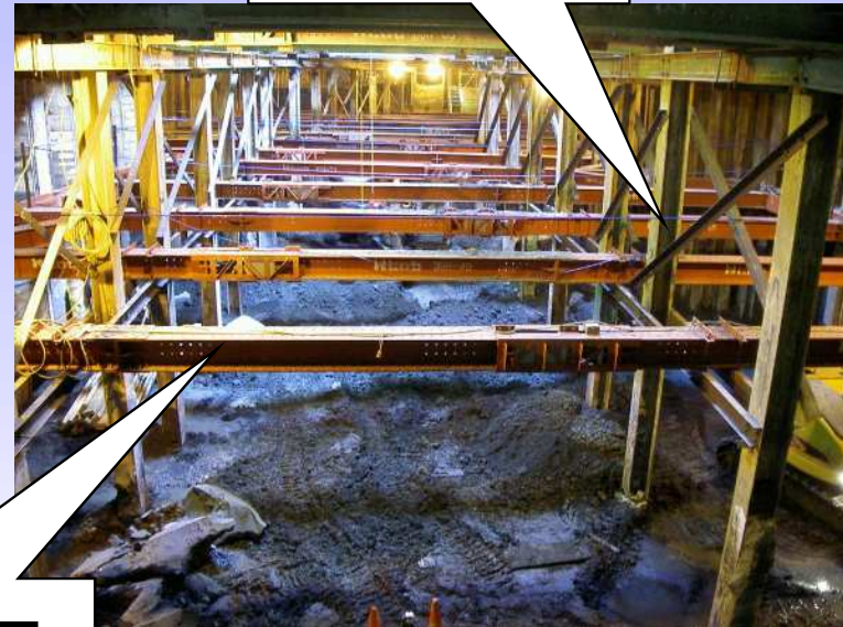
設置完了全景
