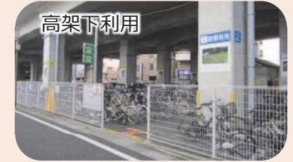
(西武池袋線の整備事例)
