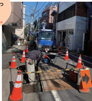
補修工事の様子
