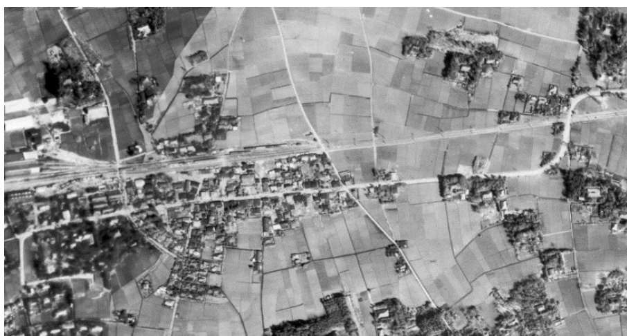
昭和 22 年当時の保谷駅周辺 ※この年に、板橋区から分離・独立し 練馬区が誕生 (出典:練馬区)
