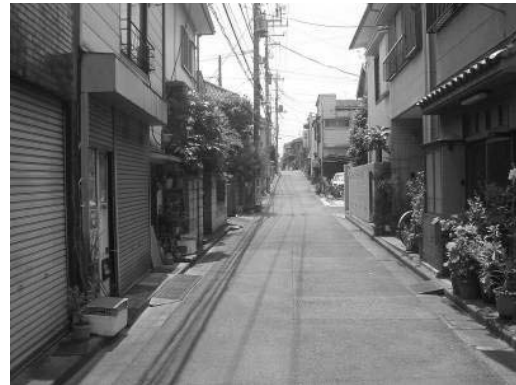
木造密集化が進む住宅地
