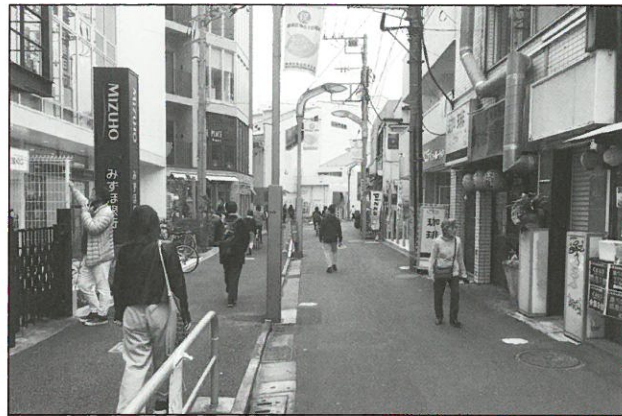
▲平成29年度整備工事予定：7号線（東側）
