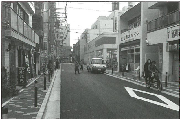
▲平成28年度整備完了：A路線5工区
