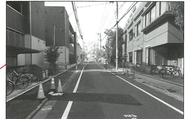
▲平成29年度整備工事中：B路線（東側）
