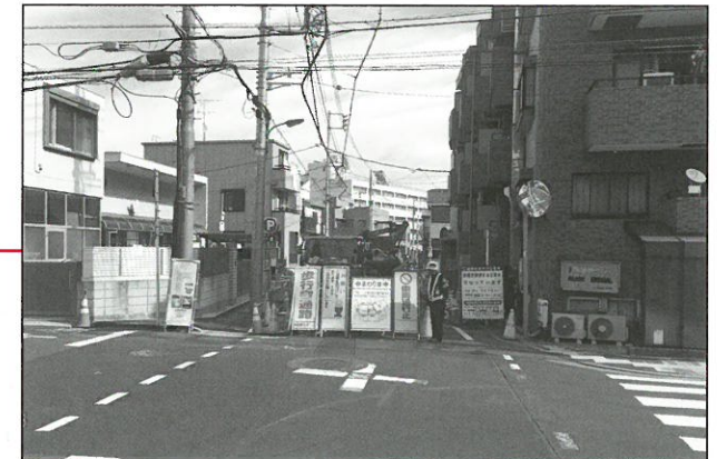
▲平成29年度整備工事中：B路線（西側）
