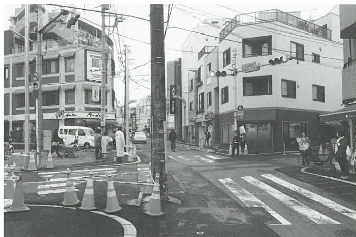
道路整備工事の様子▲
