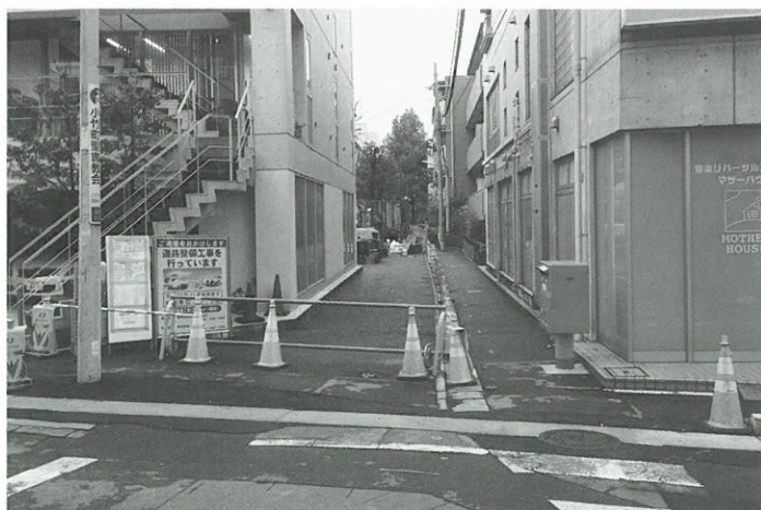
A路線4工区と江古田駅北公園をつなぐ通路▲
