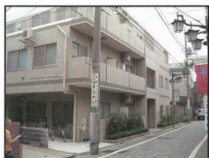
左：建替え前の状況 ○築60年以上の2棟の木造賃貸住宅
