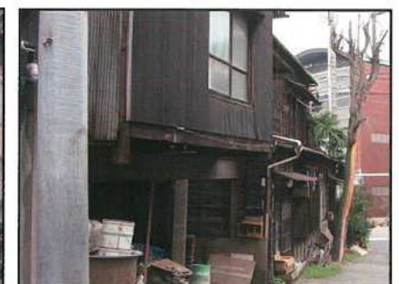
地震時に倒壊や火災の怖れのある老朽化した木造住宅
