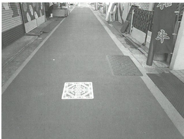
カラー舗装による道路整備 ▲
