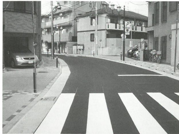
生活幹線道路A路線の整備工事▲
