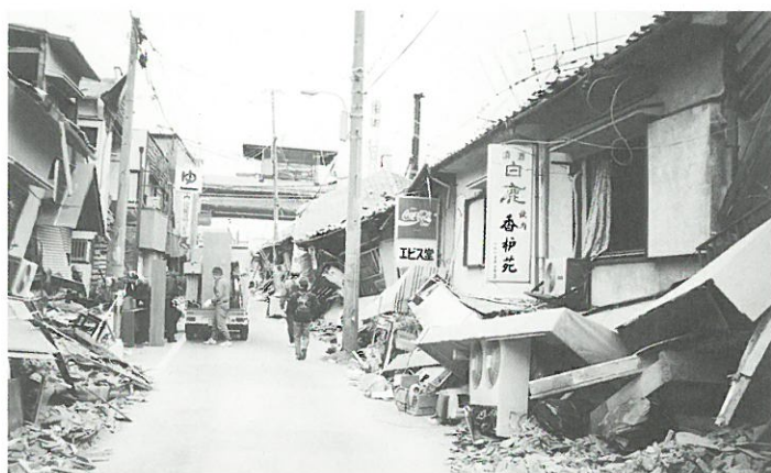
▲阪神大震災における建物の被害
