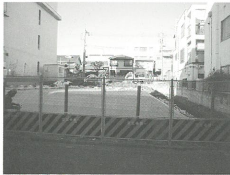
◀ 栄町40番の工事状況
