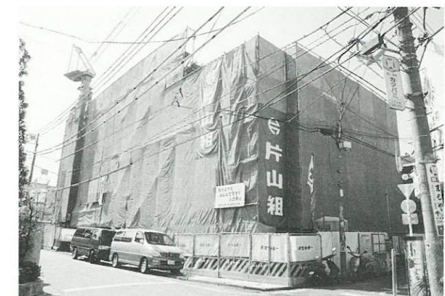
建設工事の様子
