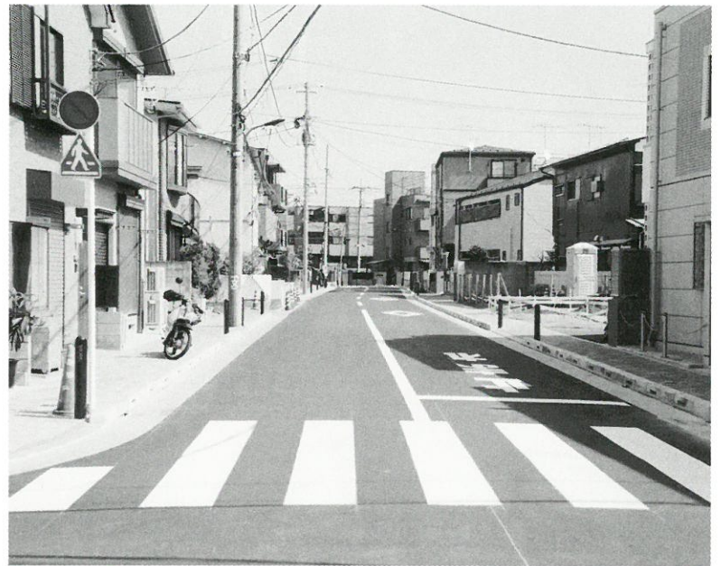
拡幅整備後の様子
