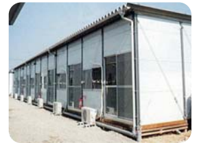
仮設住宅を建設して入居
