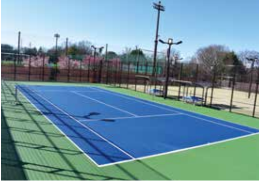
大泉さくら運動公園運動場に新設した庭球場
