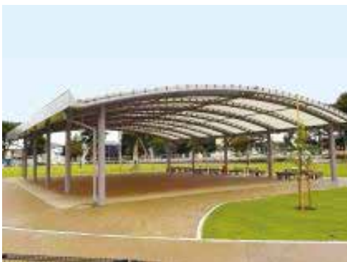
園内に設けられた300㎡の屋根付き広場
