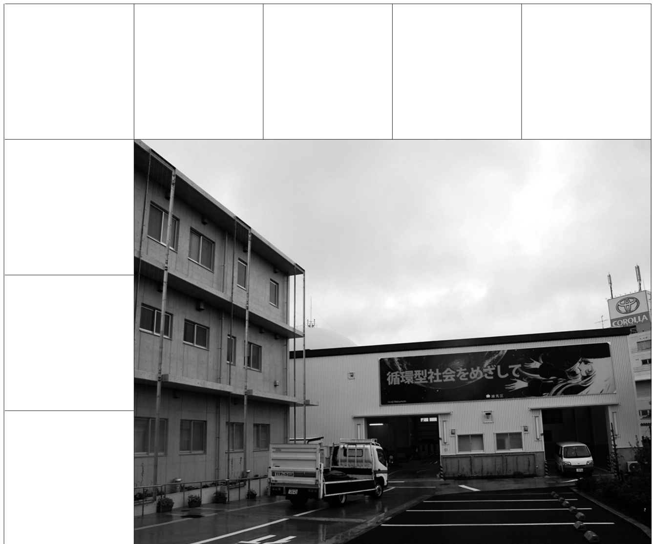
練馬区資源循環センター外観
