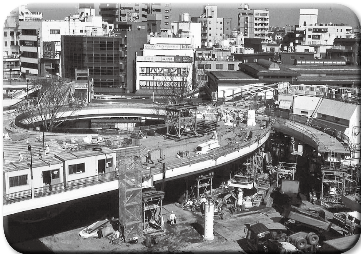
大泉学園駅（再開発工事）（平成14年12月撮影）
