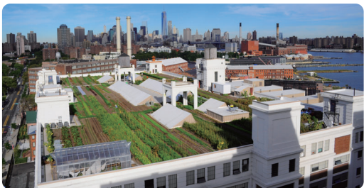
ベンチャー企業によるアメリカ最大級の屋上農園 ©Brooklyn Grange Rooftop Farm
