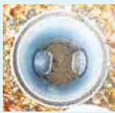
▲雨水浸透トレンチ管
