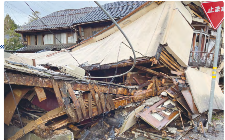
▲令和6年能登半島地震で亡くなった方の約4割が倒壊した建物の下敷きになったことなどによる「圧死」でした。また、「2000年基準」を満たさない木造住宅が数多く倒壊しました。
