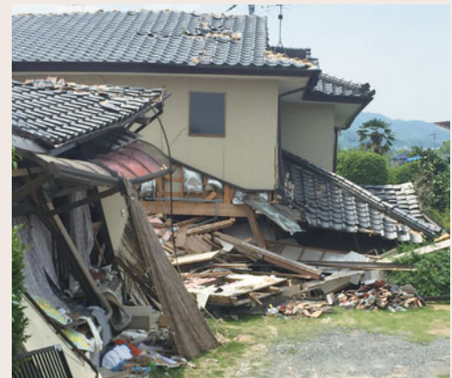
熊本地震による被害の様子
