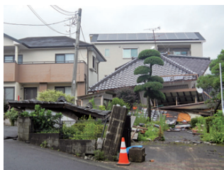
平成28年4月の熊本地震による被害の様子
