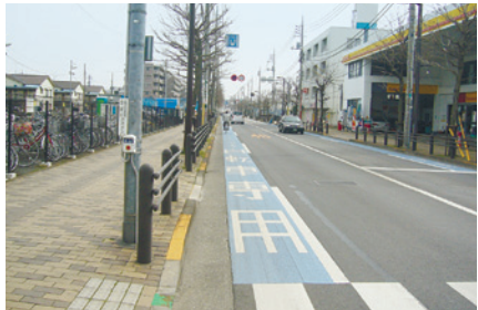
自転車走行レーンのモデル路線整備事業などを積極的に推進し、誰もが安全で快適に自転車を利用できる環境の整備に努めます
