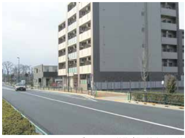
まちづくりにより整備が進む補助230号線
